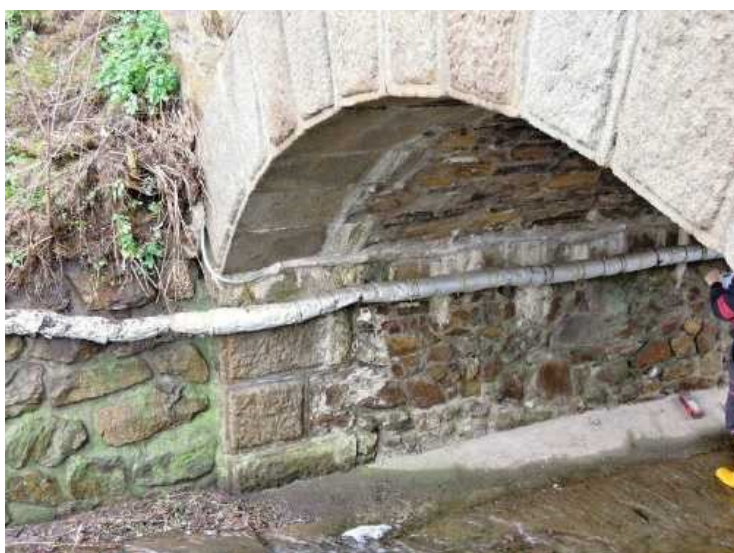
Opěra 2, levý bok, aktivní průsaky v patě klenby s výluhy pojiva.
