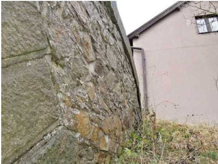
Dtto, pohled zdola na deformované křídlo.
