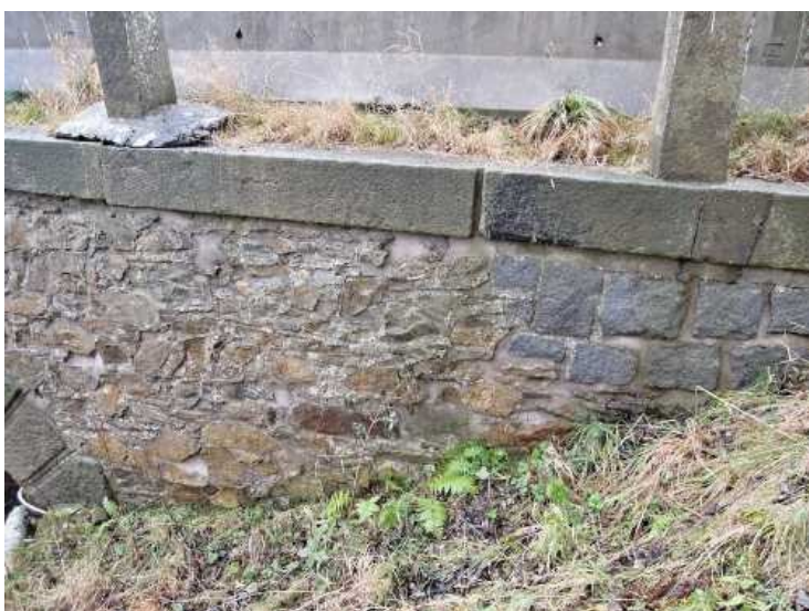
Pravé křídlo OP2 - čelní pohled na vyboulenou a vykloněnou část, plošně popraskané spárování.
