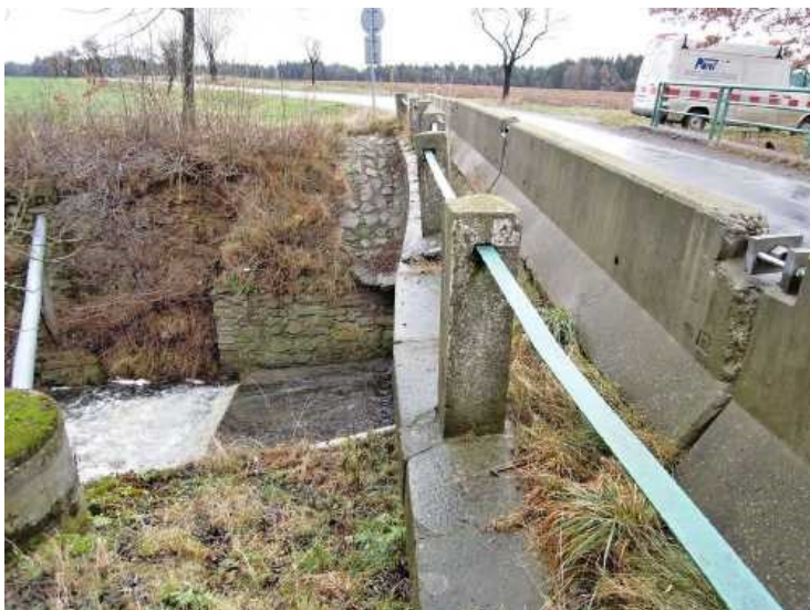
Pravá římsa - tvar kopíruje výrazné vyboulení a vyklonění pravého křídla opěry 2.
