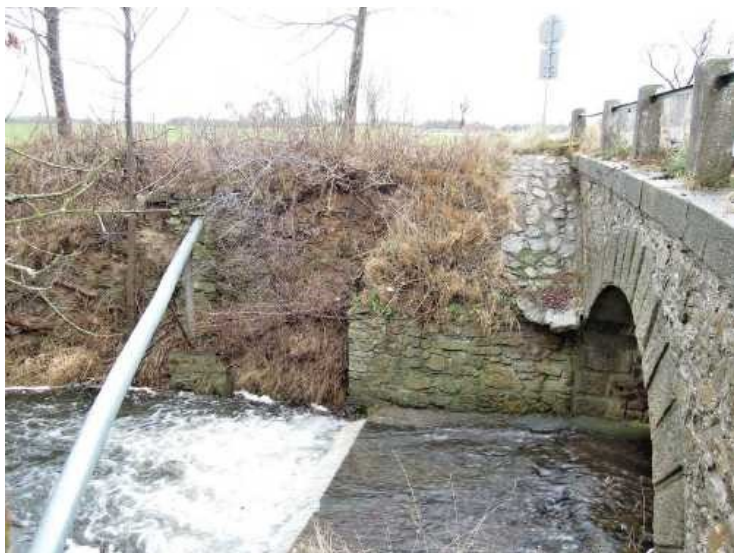
Pravá strana - erodující břeh koryta navazující na opevnění vpravo od opěry 1.
